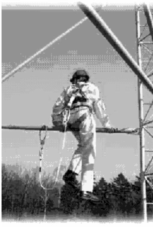
Rys. 4.12 Praca na wysokości z zastosowaniem amortyzatora [55]
