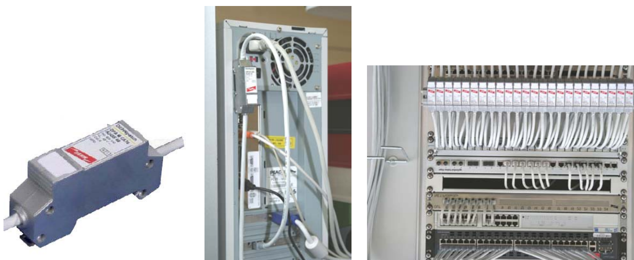
Rys. 9. Ograniczniki przepięć przeznaczone do okablowania strukturalnego klasy 6.
